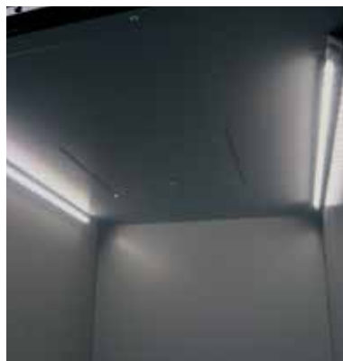
Illuminazione Cabina con barre LED
