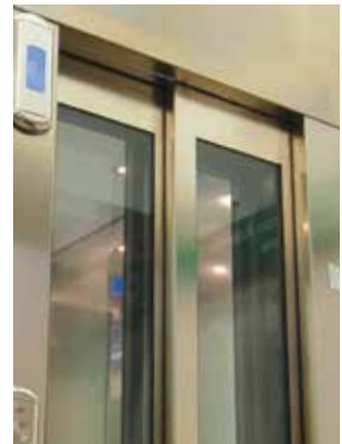
Porta di piano e cabina automatiche con vetro intelaiato "big vision" (per versione Matic)
