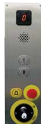
Interruttore a chiave IN-OUT per disabilitazione comandi e barriere ottiche (uso esclusivo per trasporto di sole cose)
