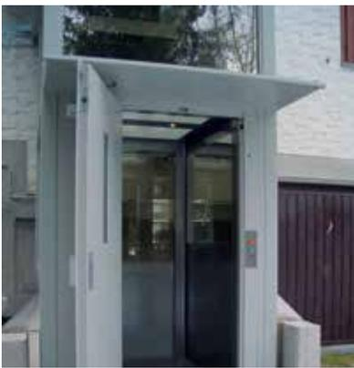
Tettoia di protezione accessi in acciaio verniciato
