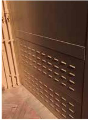
Rivestimento in lamiera con gelosie per aerazione
