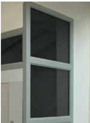
Profili fermavetro e guarnizione con installazione dall'INTERNO della struttura (per ambienti interni)
