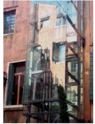
Rivestimento con vetro esterno struttura e borchie di fissaggio in inox
