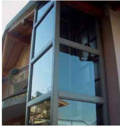
Profili fermavetro e guarnizione con installazione dall'ESTERNO della struttura
